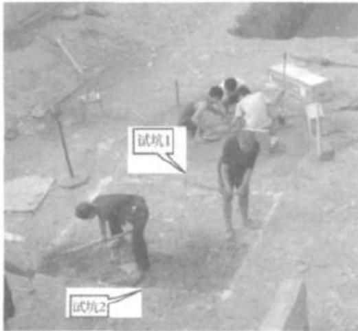
图2 试坑开挖和填筑照片
