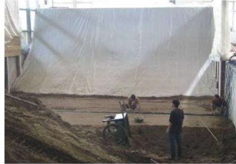
图14 铺设好的双层塑料薄膜
